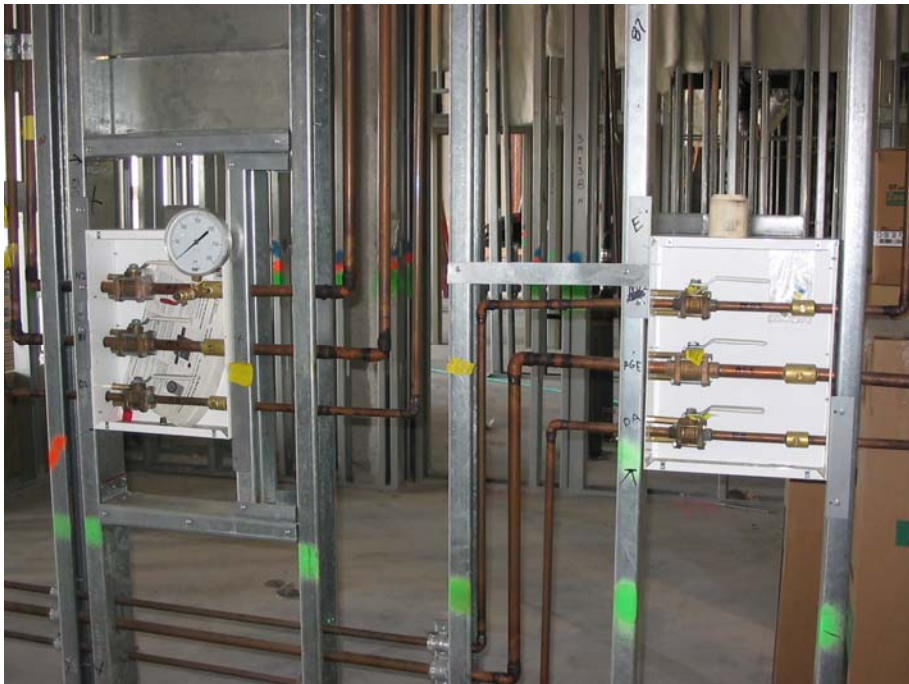
Med Gas Shutoff Valves
